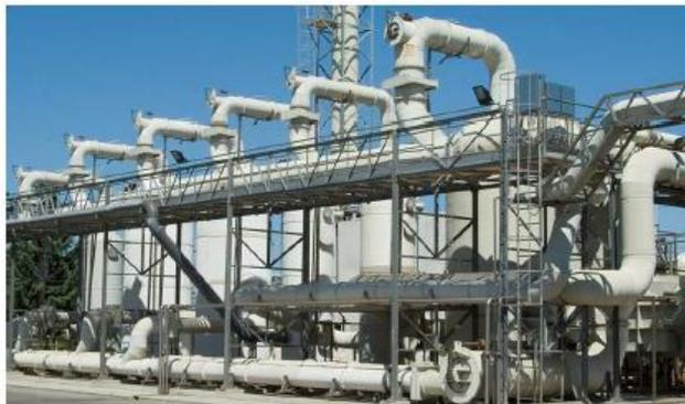
Il livello di H<sub>2</sub>S in uscita dai singoli stadi e l'emissione finale al camino viene monitorato in continuo mediante gascromatografia (Agilent 7890B) e un sistema di campionamento delle emissioni all'uscita delle singole torri (scrubber) da T1 a T6, nonché all'ingresso dello scrubber a due stadi finale e in uscita al camino (emissione **E1**).
