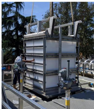
Figura 39. a) Membrana FibrePlate; b) schema di rappresentazione della cassetta; c) installazione di una cassetta nel relativo pozzetto di filtrazione sull'impianto.
